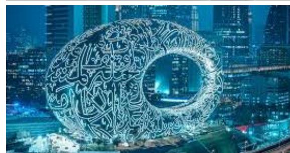
Se proyectó utilizando el “diseño paramétrico”, un modelado informático en 3D basado en introducir datos, conceptos y modelos geométricos y matemáticos para aplicarlos al edificio que se quiere diseñar. Los 1.024 paneles de su fachada de acero inoxidable se fabricaron con brazos robóticos automatizados.
